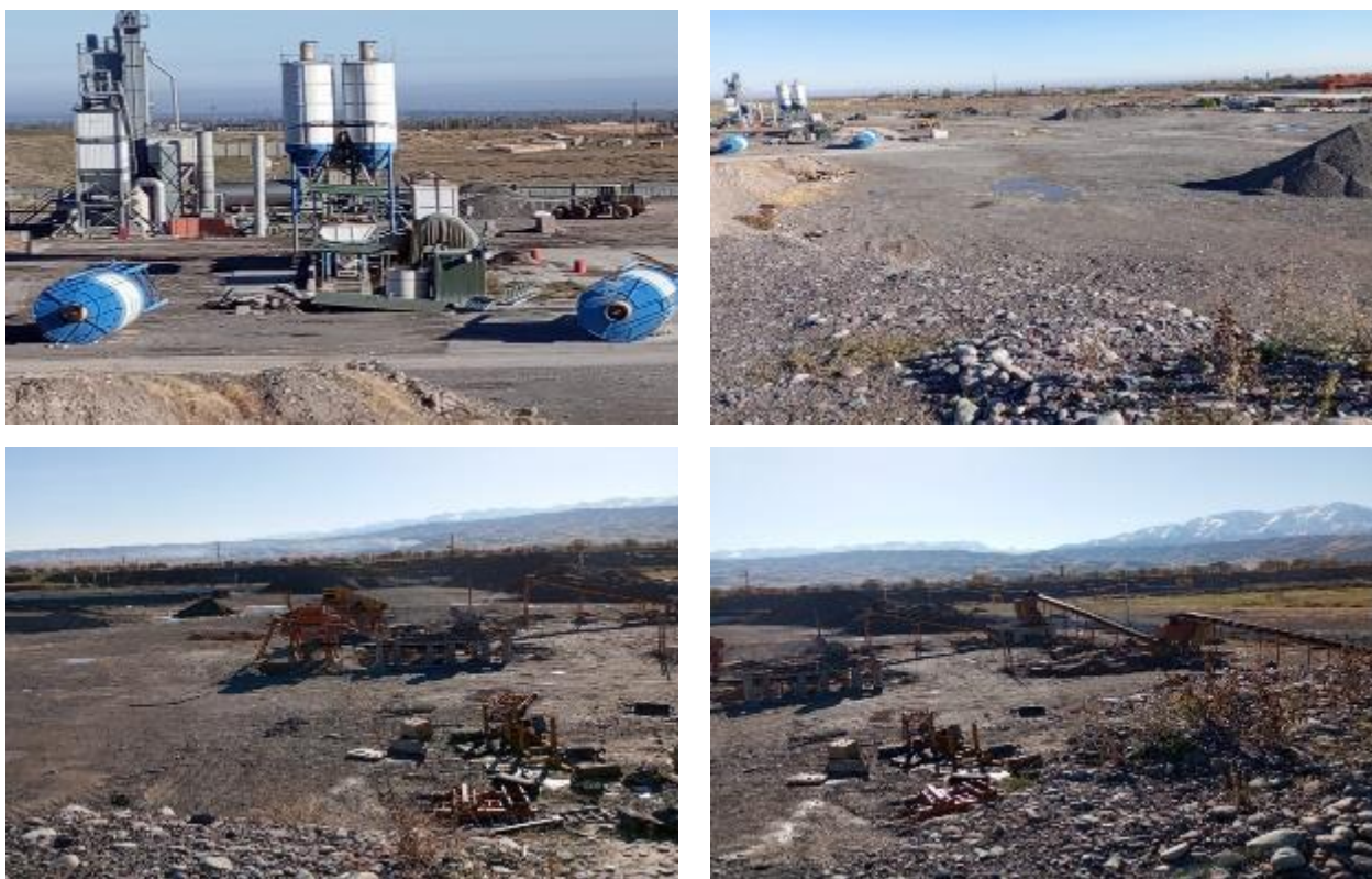
Рисунок 5. Демонтаж оборудования на территории промплощадки.
