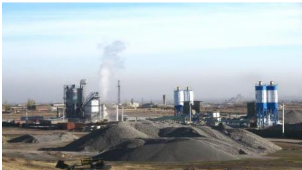
Рисунок 4. Производственная площадка. Бетонно-смесительный завод. Асфальто-битумный завод.
